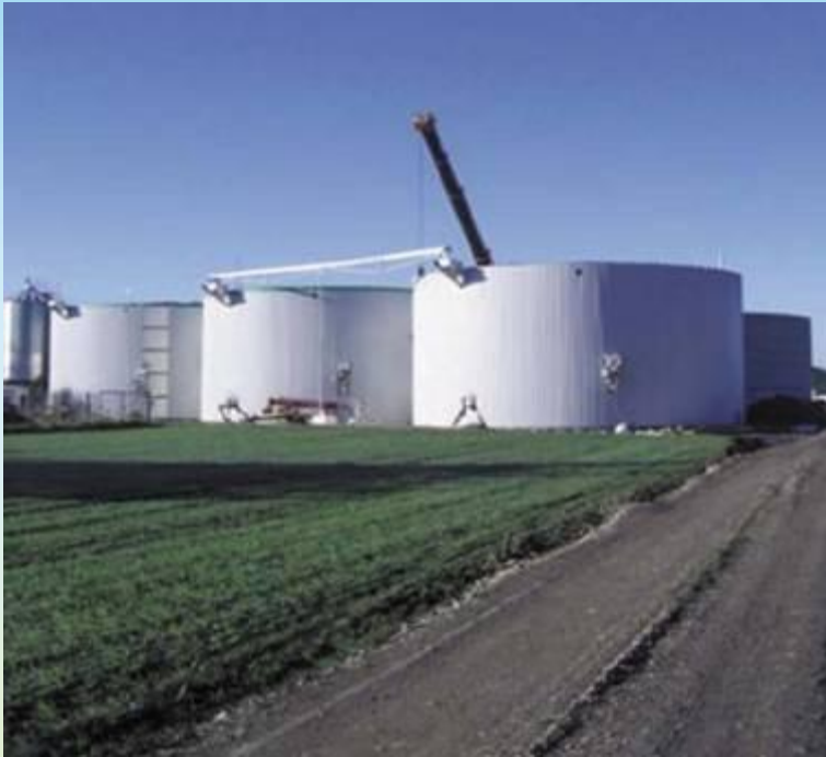
Biologisch 5 MW Biogas (Methan)
